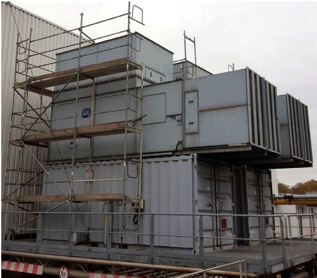
Abdichtung von Gohl Kühltürmen, Nennleistung 3.000 kW
