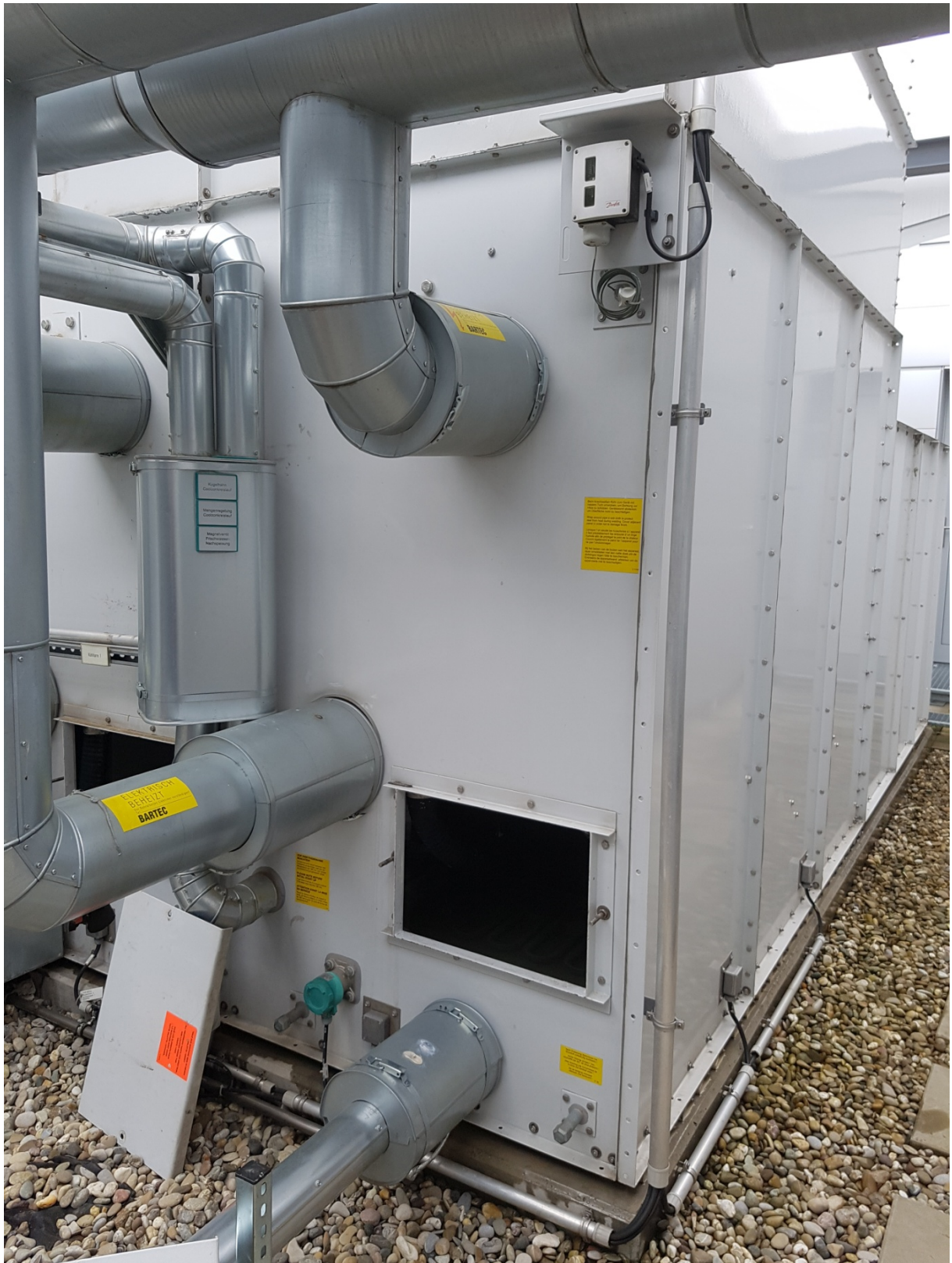
Service an Gohl Kühlturm
