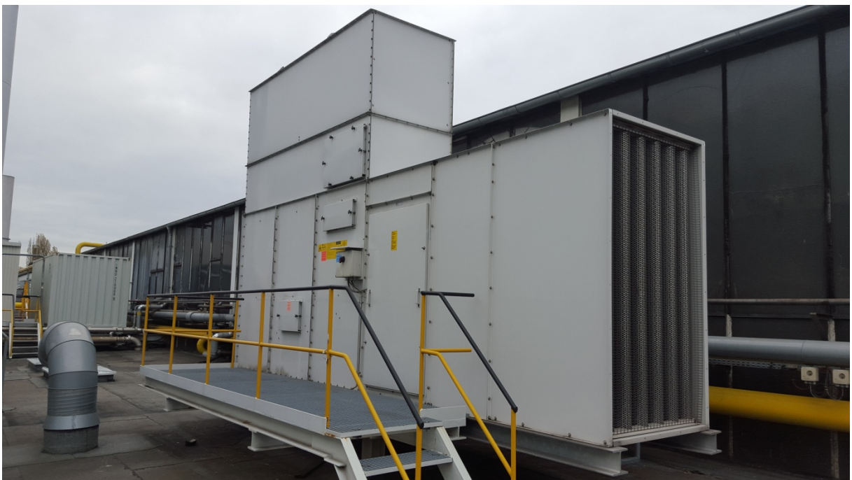
Erfolgreiche Abdichtung eines Gohl Kühlturms
