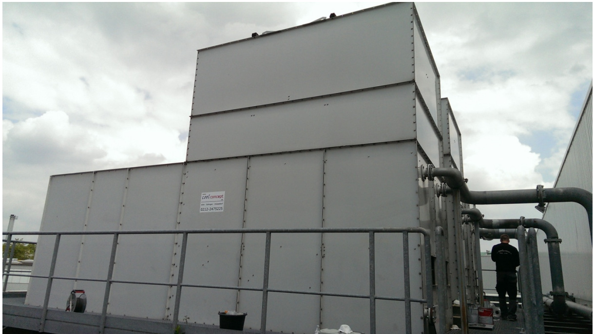
Abdichtung von Gohl Kühltürmen, Nennleistung 3.000 kW
