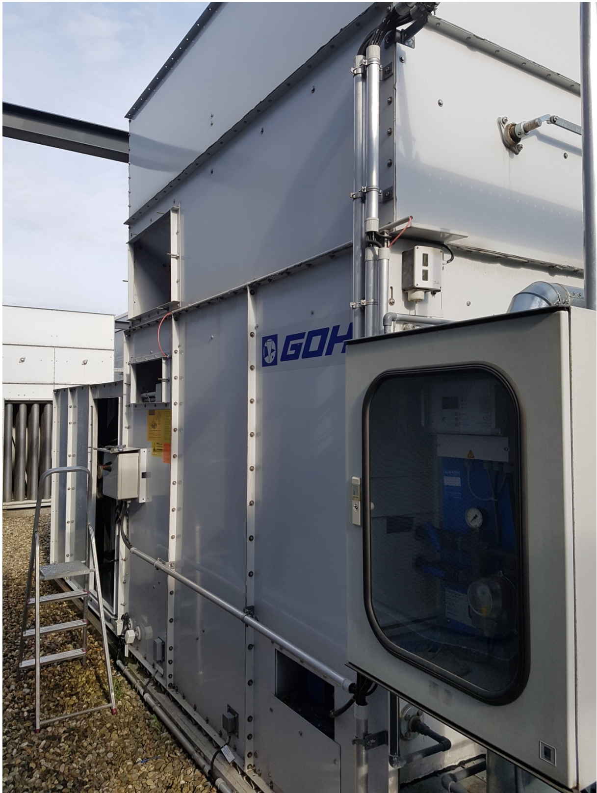
Service an Gohl Kühlturm zur Kühlung von Kälteanlagen mit Turboverdichtern
