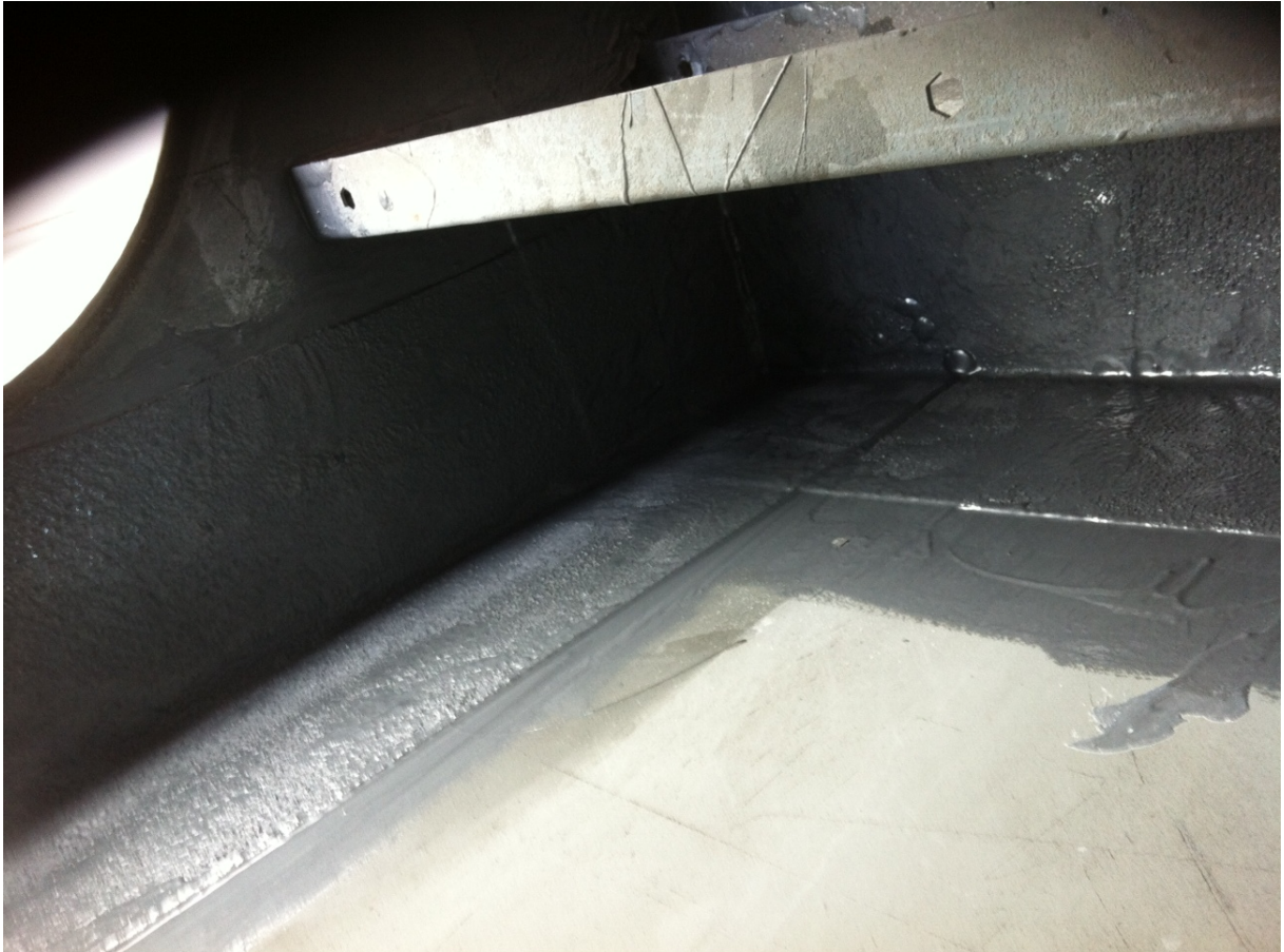
Abdichtung eines Gohl Kühlturms durch eigenes Verfahren
