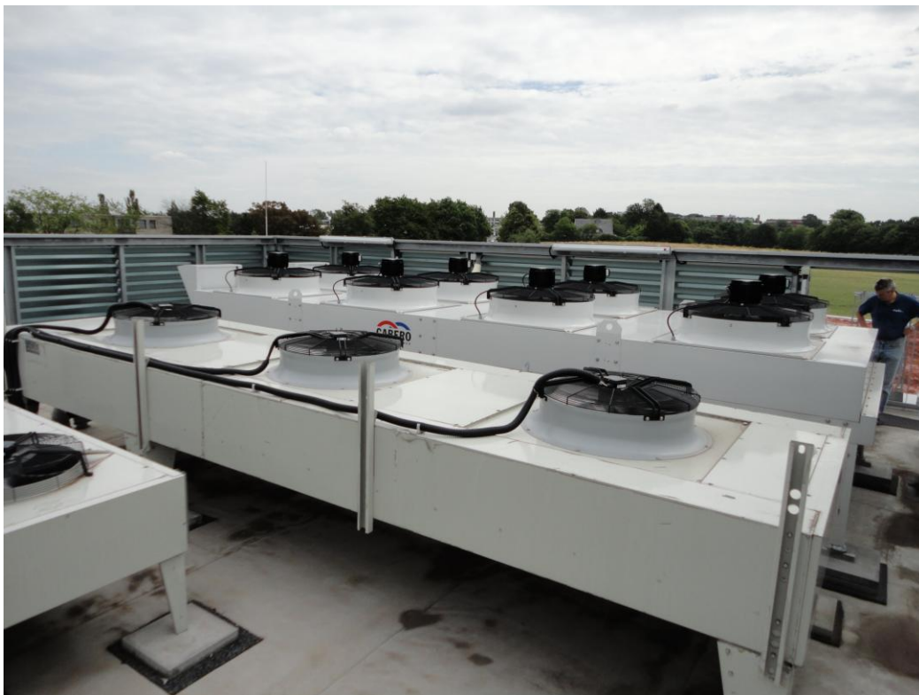
Cabero Verflüssiger zur Kühlung von Schraubenverdichtern
