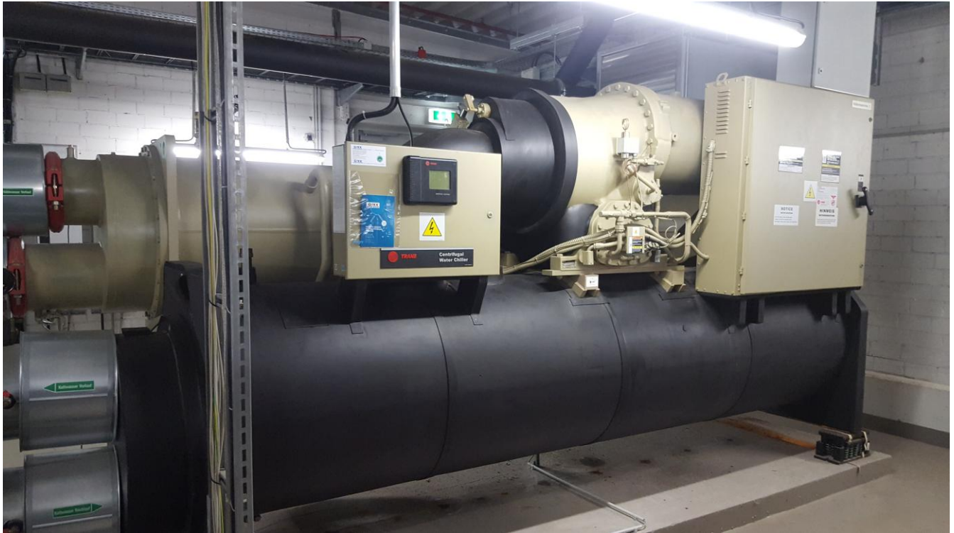
Kälteanlage mit Turboverdichter 2.200kW Kälteleistung
