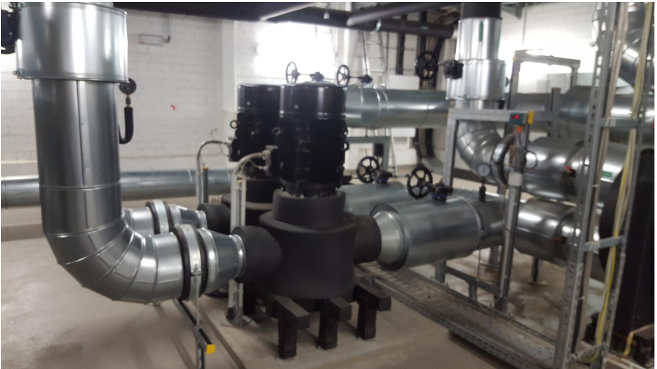
Kühlwasserpumpen
