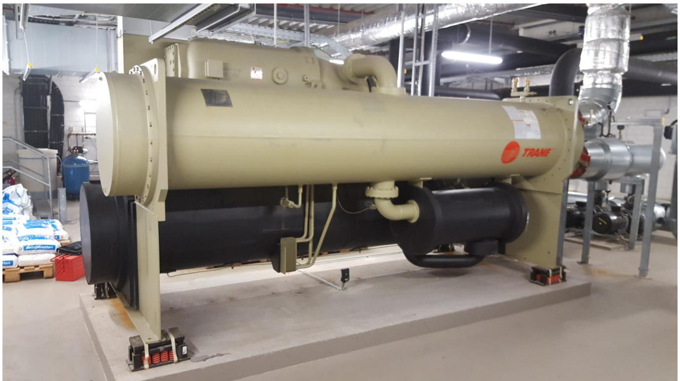
Kälteanlage mit Turboverdichter 2.200kW Kälteleistung
